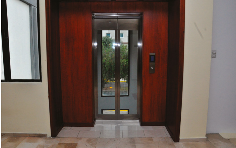
Adquisición e instalación del sistema de movilidad vertical (ascensor).
