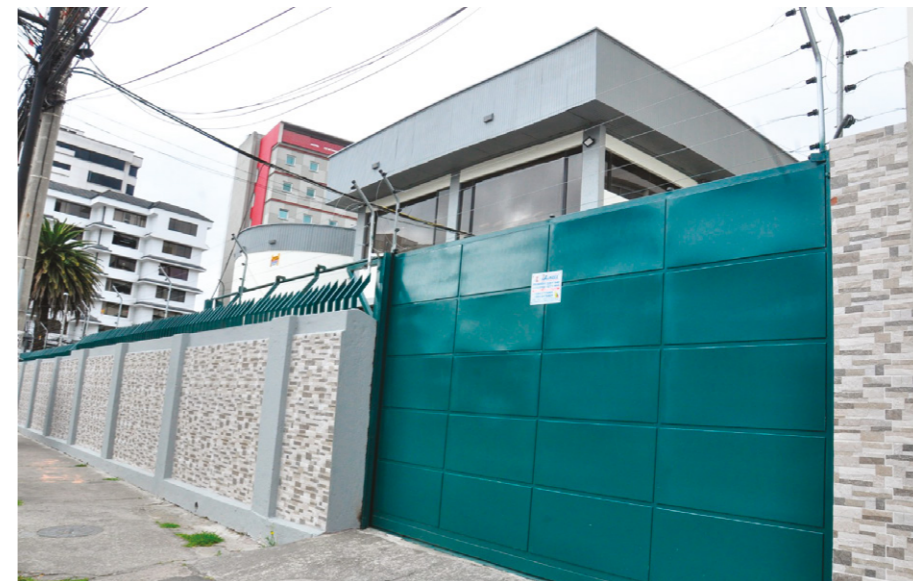
Adquisición e instalación de la puerta de salida vehicular.
