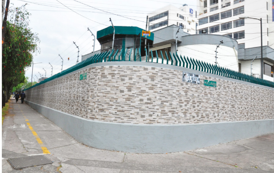
Instalación de cerámica en la fachaleta exterior y cerca eléctrica.
