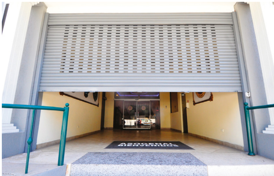
Adquisición e instalación de puertas automatizadas.
