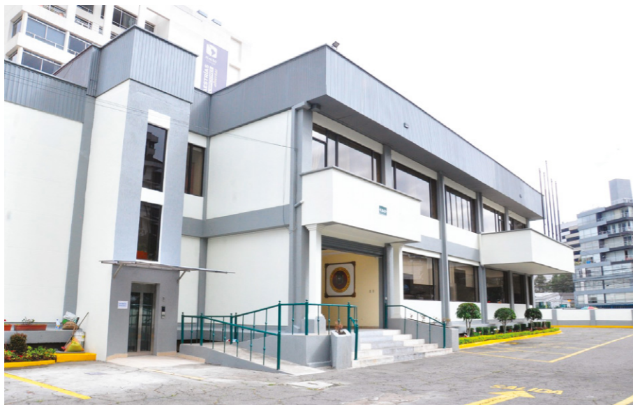
Cambio de pintura exterior e interior.
